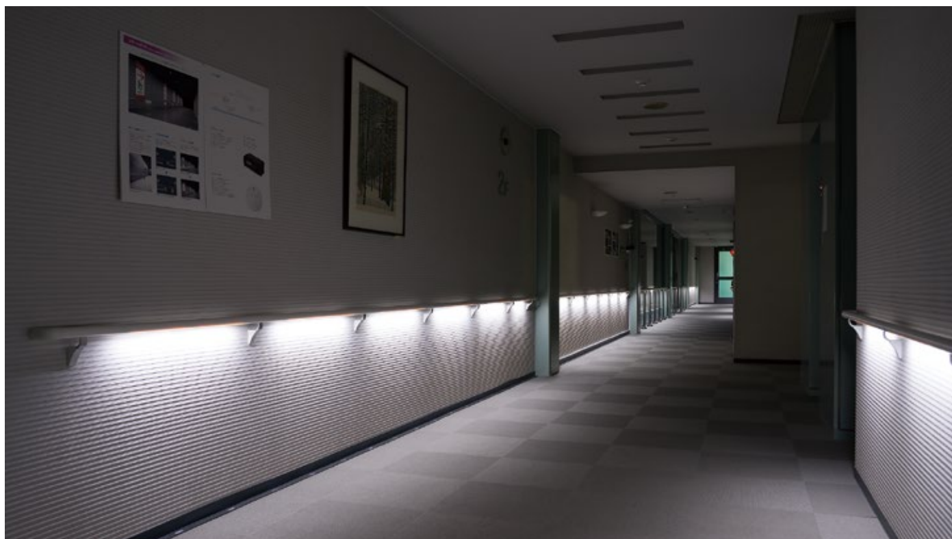
火災時を想定して室内灯を消した状態で煙を発生させて効果を検証します。
